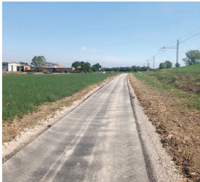
PONTE GHIARA Il tratto di ciclabile ripristinato dal Comune.
